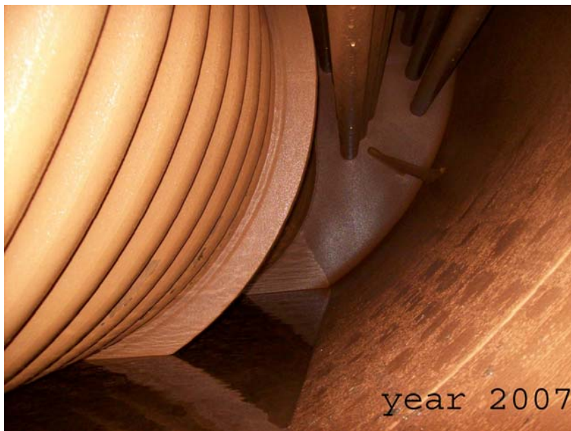
สภาพภายในหม้อไอน้ำก่อนใช้สารเคมี Textreat430
